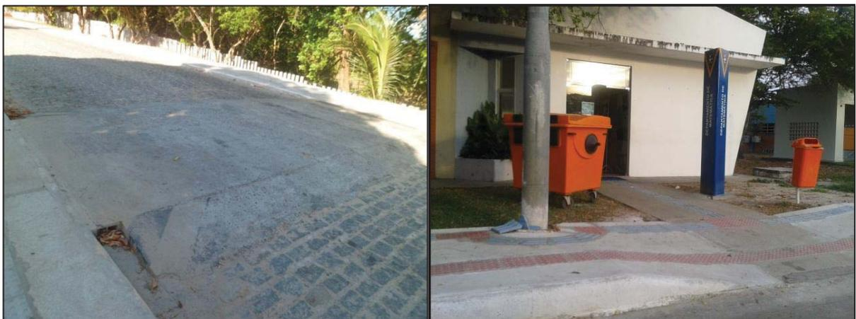
**Figura 4.7:** Pontos de travessia: um com faixa elevada e outro com rebaixamento de guia
