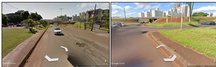
Figura 3: Vista da Rua Constantino Pialarissi
